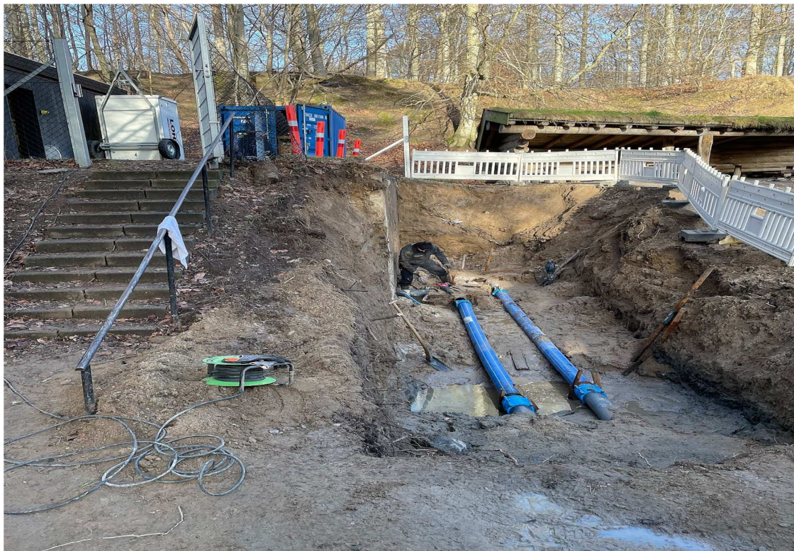
Ledningsarbejde ved rentvandstanken
